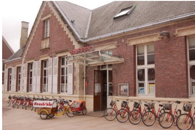
Local de l'association Beauvélo à la gare de Beauvais
